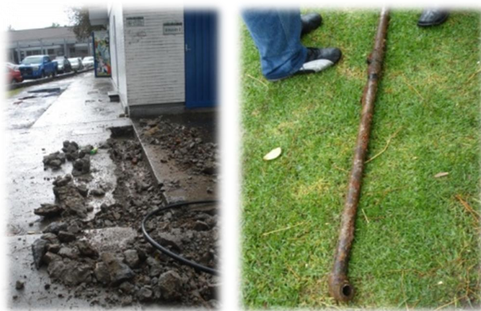
Figura 5. Trabajos de recuperación de caudales. En la imagen, una fuga localizada y reparada.
