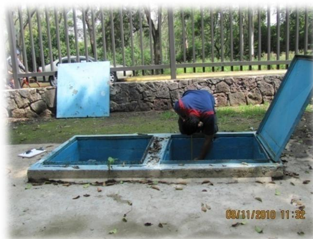
Figura 7. Trabajos de levantamiento de cisternas de agua potable.
