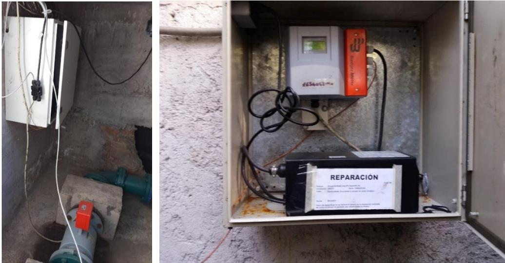
Figura 11. Equipo electromagnético instalado para la macro medición en CU
