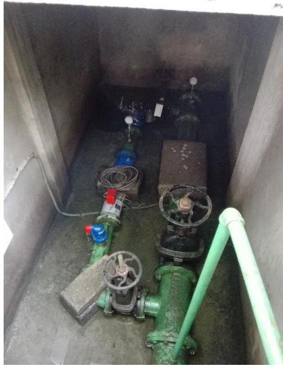
Figura 7. Arreglo actual de la caja de válvulas en el punto de suministro del sector 3
