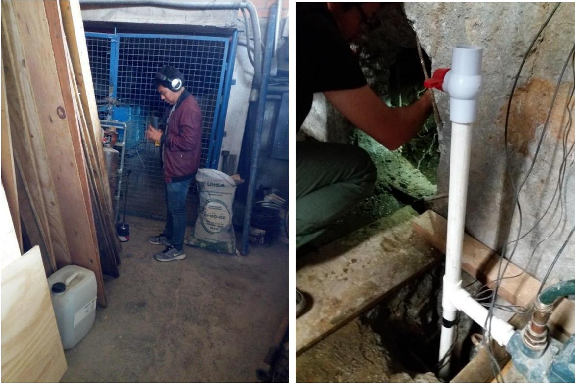
Figura 10. Trabajos de búsqueda de fugas dentro de edificios de las dependencias universitarias
