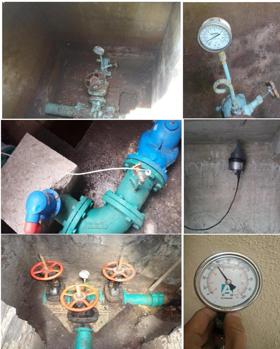
Figura 15. Campaña de medición de presiones y sensor de presión con data logger
