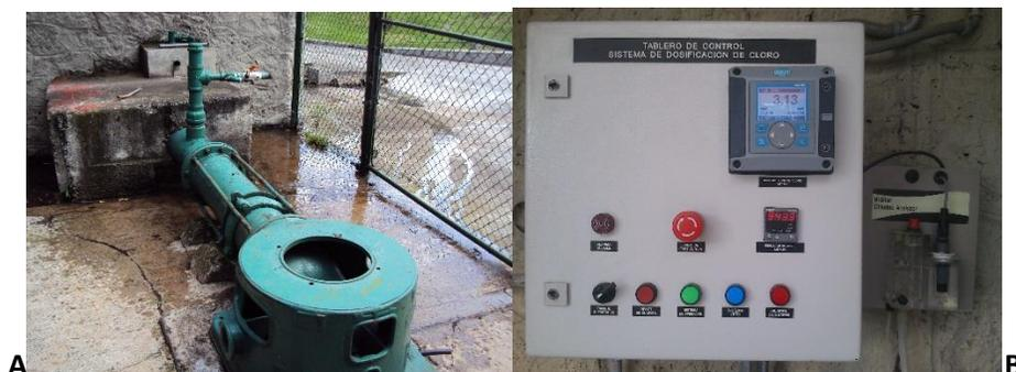
Figura 1. A. Pozo de extracción (Multifamiliar), B. Sistema de desinfección automático
