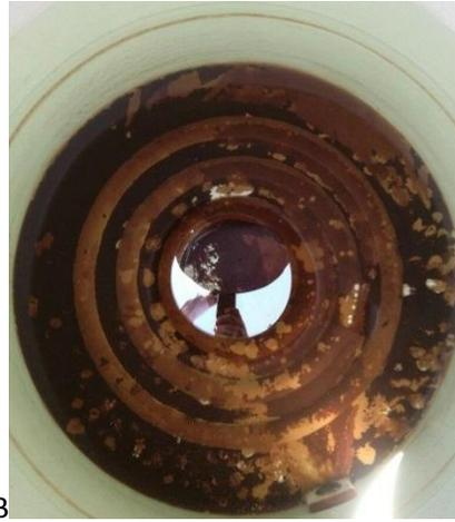
Figura 8. A Cisterna de almacenamiento de agua B Sedimentos acumulados en el fondo de la cisterna
