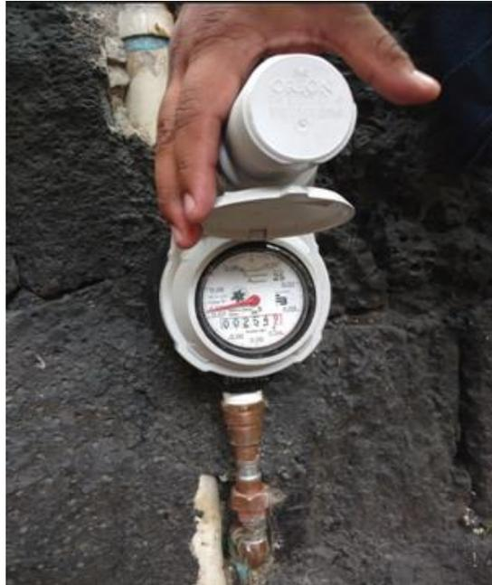
*Figura 9. Medidor instalado en el bebedero de la Facultad de Psicología*
