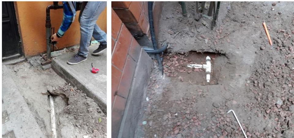
Figura 23. Levantamientos y calas para elaborar plano de la red en Los Rojos
